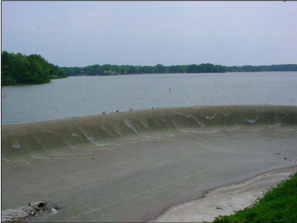
Lake Bloomington Spillway
