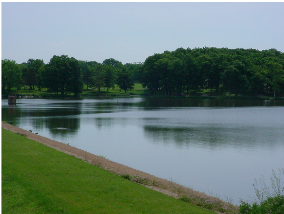
Lake Taylorville: Spillway
