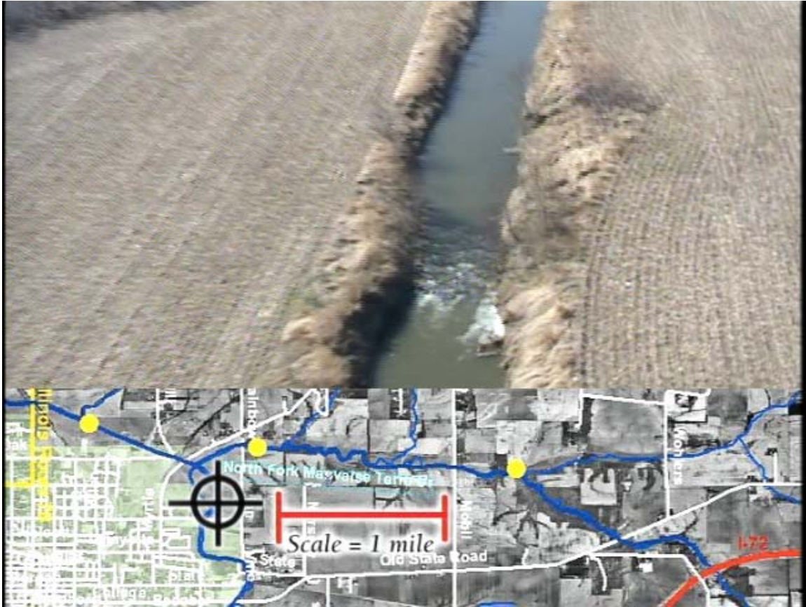
Fig. 5 Existing Rock Riffle—Mauvaise Terre River
