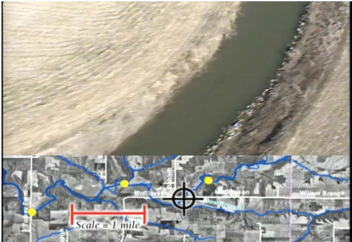
Fig. 6 Stone Toe Protection on Mauvaise Terre River above confluence with Willow Creek.
